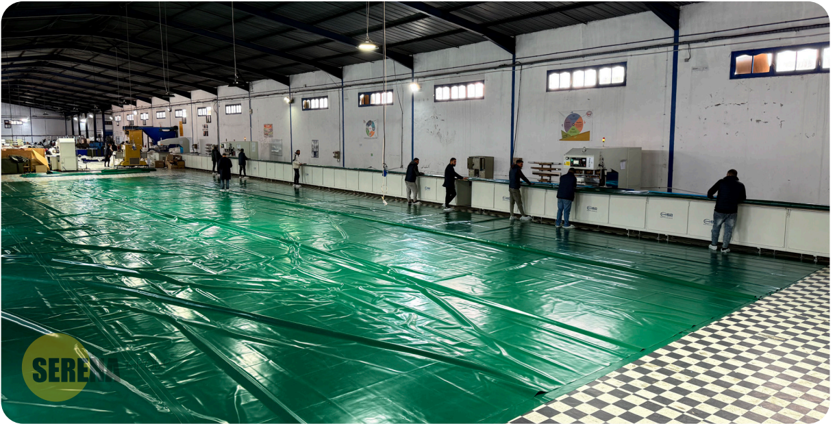
Fabricación de un tanque de 1000 m 3
